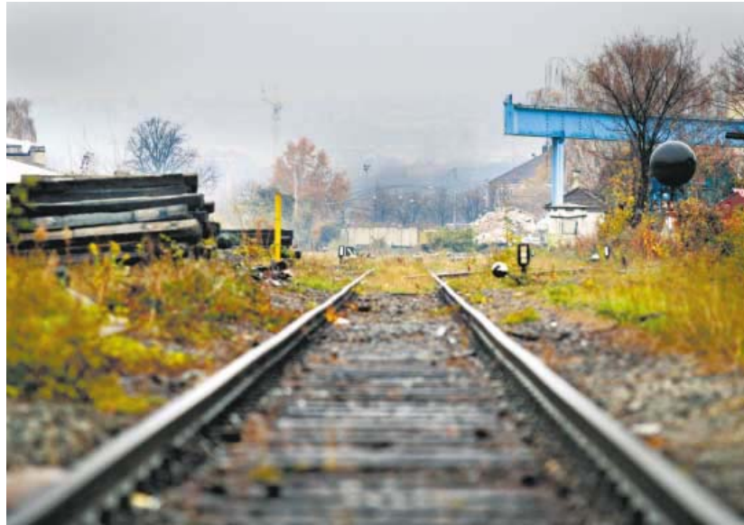
Auf dem Gelände des Güterbahnhofs ist noch viel zu tun, bis mit dem Wohnungsbau begonnen werden kann.
